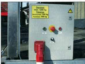
einfaches Aufbauen der Bühne mit 230V Elektrik
