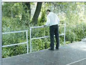
Geländer (3-seitig) als Absturzicherung
