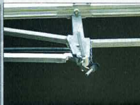
Fallstreben sichern das Dach
